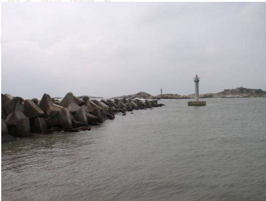
航道標誌燈(復國墩漁港)
